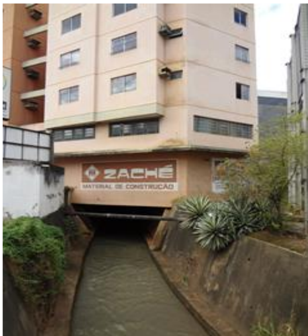
Figura 3-44 - Vista para o córrego do Ouro, no bairro São Silvano.
