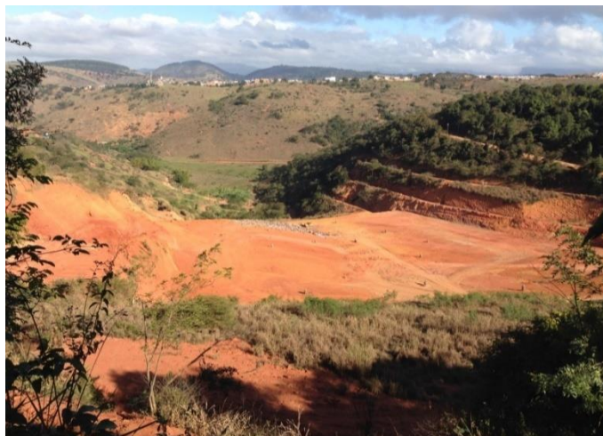
Figura 3-54 - Vista do Aterro Controlado do município.
